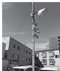
あさぶ商店街駐車場の防犯カメラを更新
